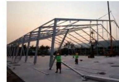
اختبار وتحمل الهيكل الإنشائي Structural testing before loading
