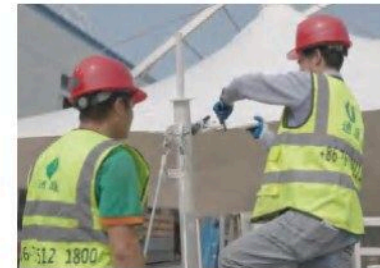
تركيب تجريبي قبل التحميل Trial installation test
